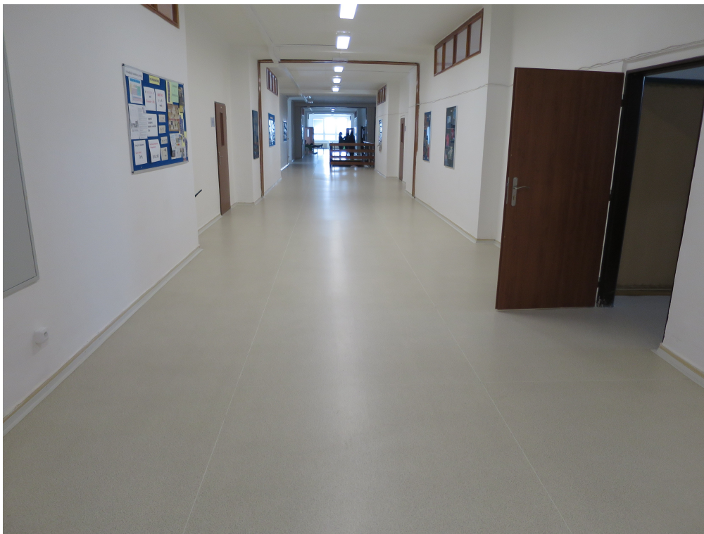
Nová podlaha v II. nadzemním podlaží
